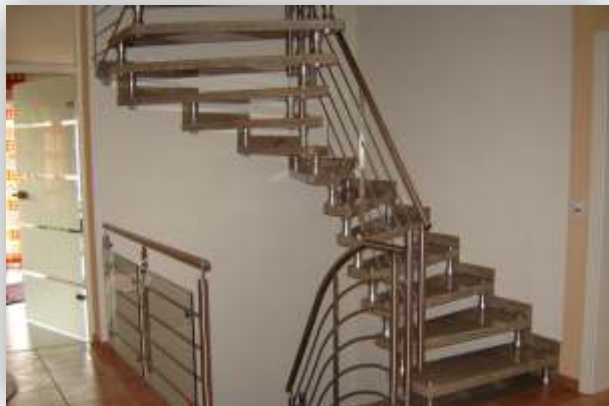
freitragende Treppe aus Juparana Colombo
