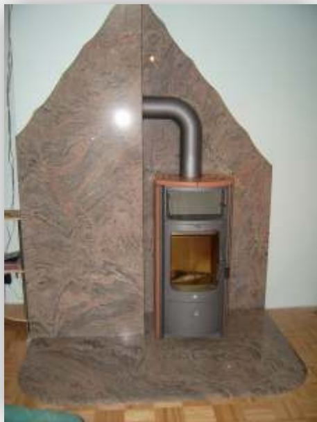
Ofenrückwand und Bodenplatte aus Juparana Colombo
