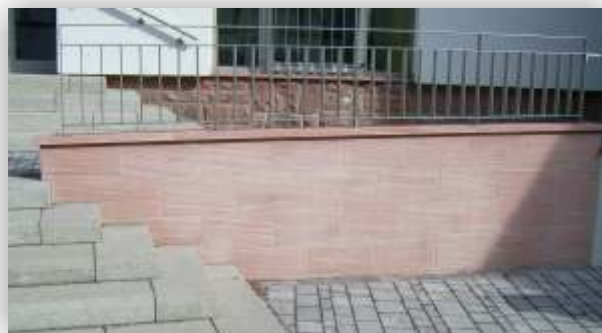
Verblendmauerwerk aus gebänderten Mainsandstein
