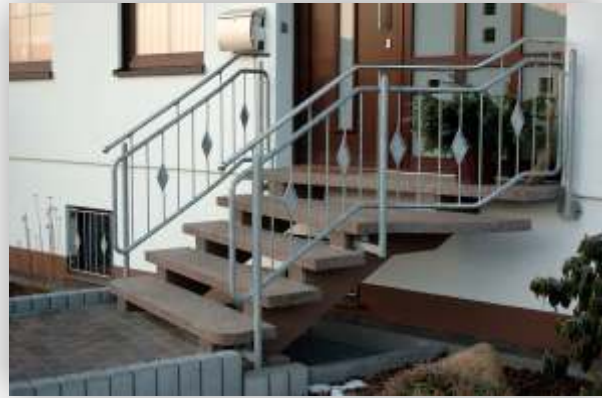
Außentreppe, auf Sichtbetonstegen verlegt, aus Balmoral
